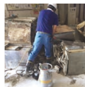
ガス回収作業の様子
