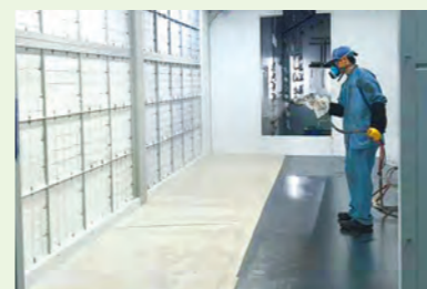
乾式溶剤塗装ブース
