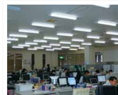
LED照明に切替え
