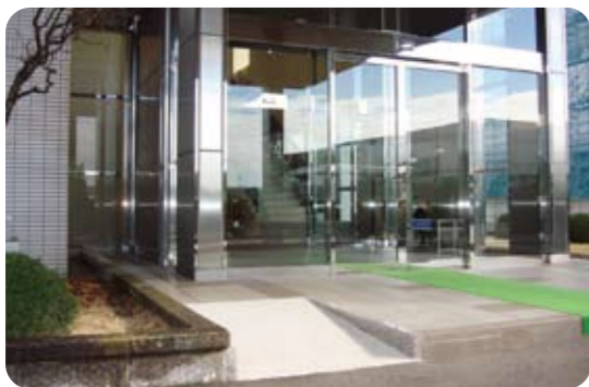
設置したスロープ
